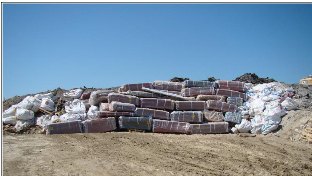
Figura 3 – Abbancamento RCA nella discarica del Tiro a Segno
