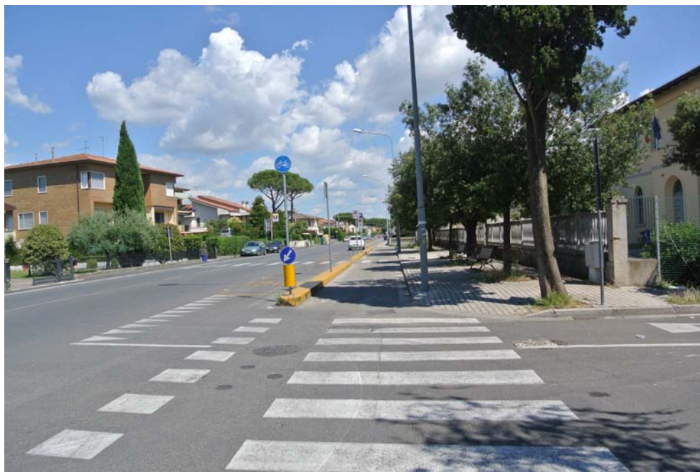
Fig. 3.5.3 - Esempio di pista in sede propria lungo la Tosco Romagnola a Cascina
