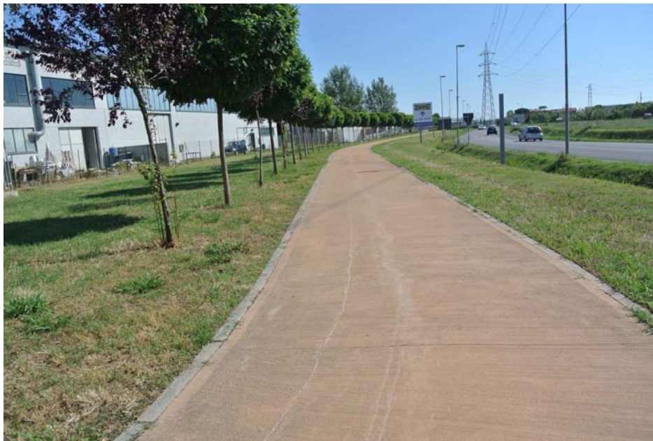
Fig. 2.2.11 - Particolare del percorso in v.Oristano
