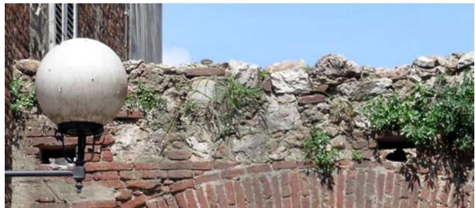
*A sinistra: muratura mista di pietrame con ricorsi in mattoni e, sopra, un esempio con ricorsi in spessore e di costa (volta). La parte superiore incompleta e la vegetazione sono elementi di degrado.*
