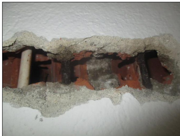
Foto n°4 - Dettaglio dell'analisi della profondità di carbonatazione eseguita sul travetto in calcestruzzo.
