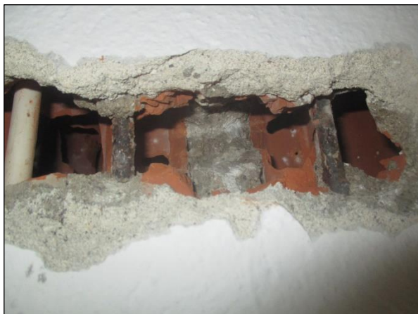
Foto n°3 - Individuazione della Tipologia di solaio 2; demolizione eseguita al piano terra.
